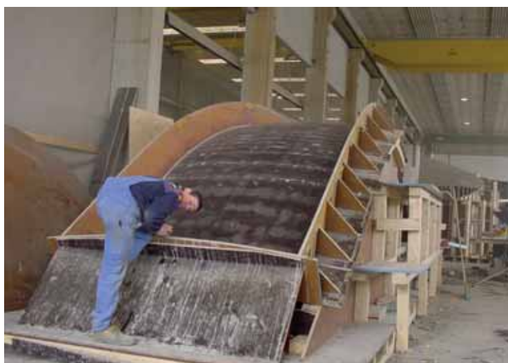
Abb. 3: Der Schalungsbau im Werk
