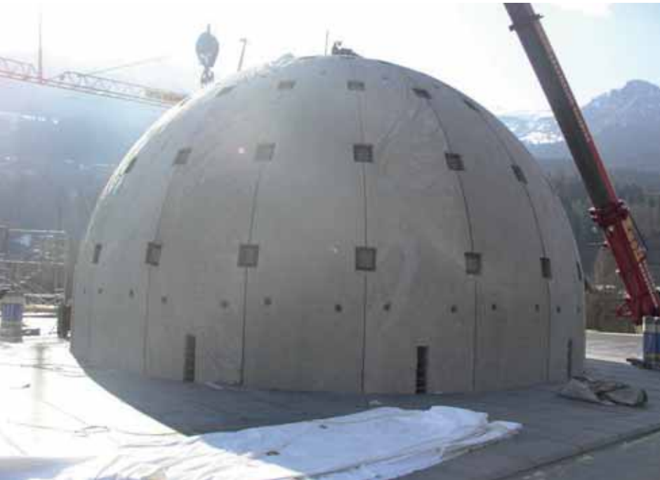
Abb. 1: Die fertig zusammengebaute Kuppel
