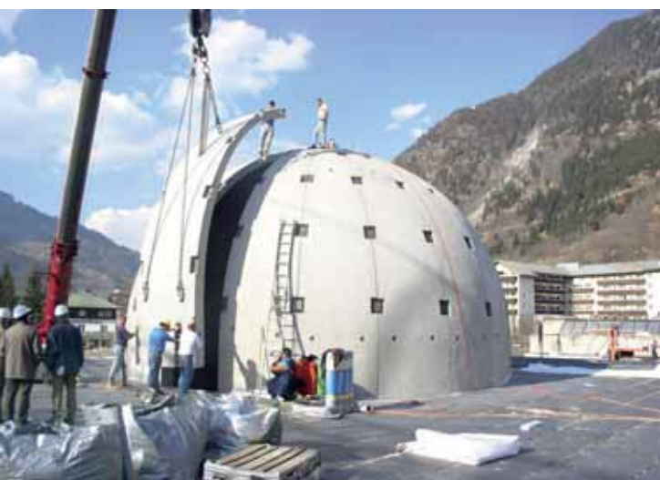
Abb. 2: Einheben des letzten Segments
