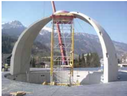
Abb. 5: Wechselseitige Montage der Einzelteile
